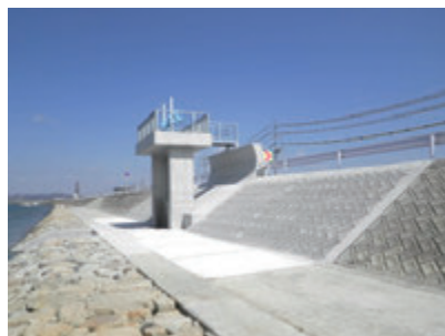
高梁川連島排水機場吐出樋門新設工事
