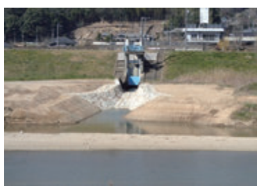
高梁川上流維持工事後
