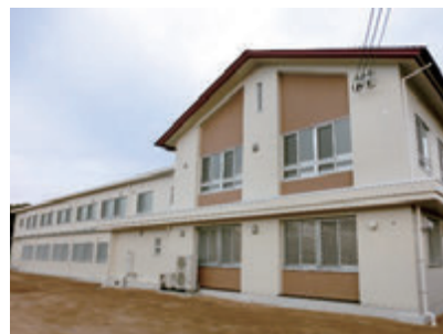
県立倉敷中央高等学校耐震補強等工事
