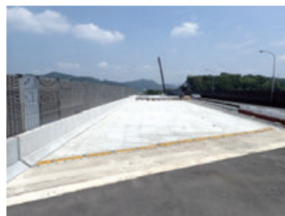
国道2号西大寺中野 IC 高架橋床版工事
