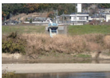
高梁川上流維持工事前
