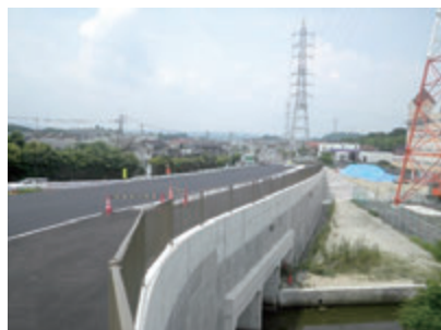
水島港水島玉島地区臨港道路（玉島側） 取付部改良工事
